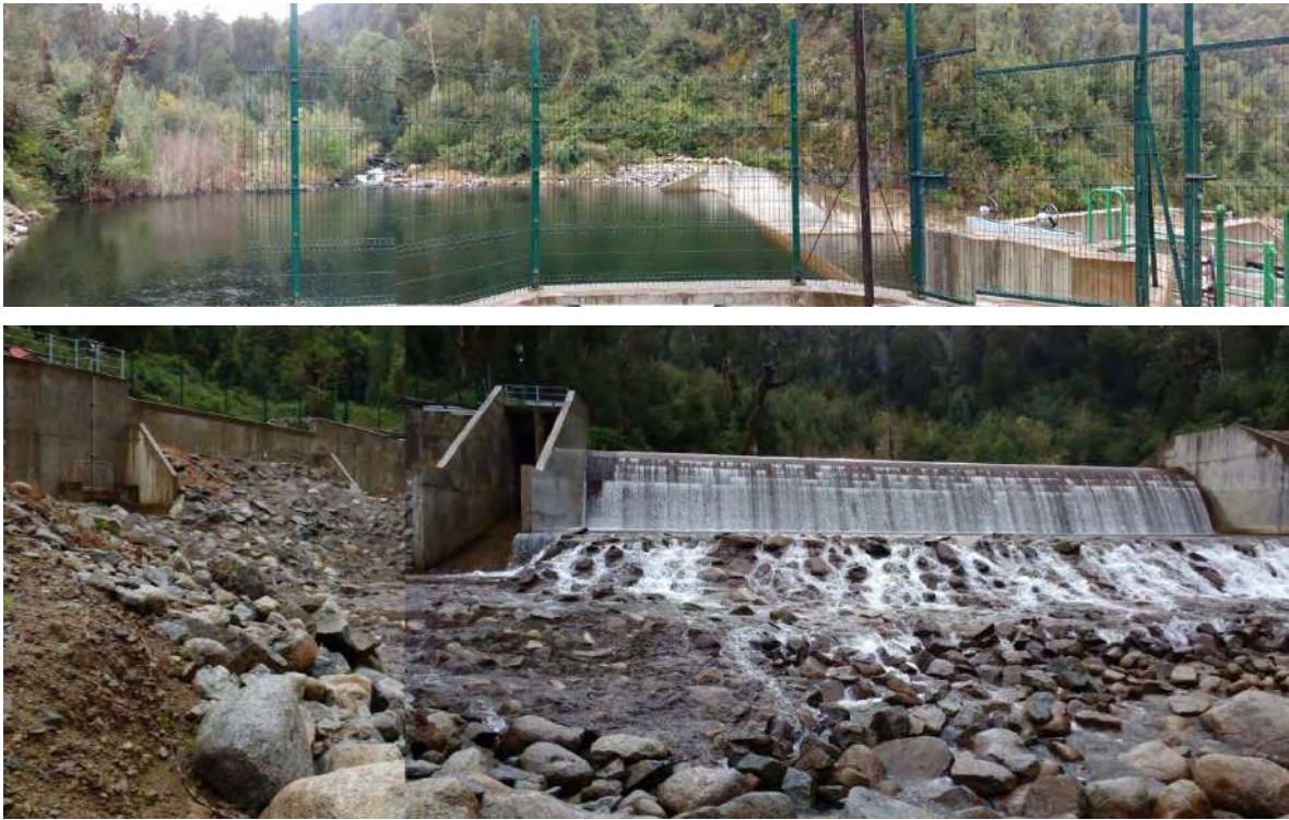
Fig. 49: Bocatoma de la planta hidroeléctrica en el río Quiman
