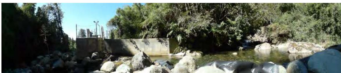
Fig. 134: Bocatoma de la planta hidroeléctrica “Pitreño” en el río Pitreño
